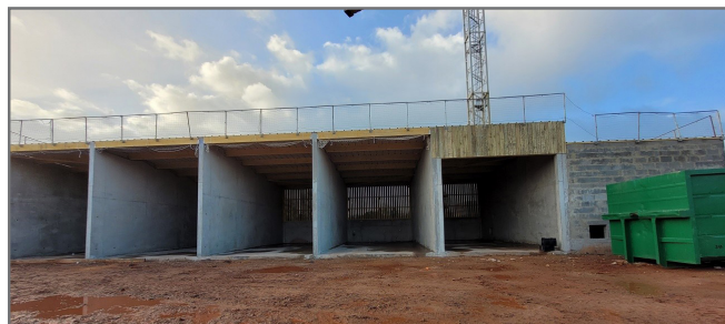
Mise en œuvre de la couverture sur le bâtiment chaufferie
